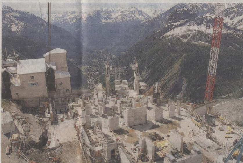
Il cantiere per la costruzione dell'avveniristica funivia del Monte Bianco
