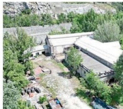
Ancora l'ex area industriale di Saint-Marcel
