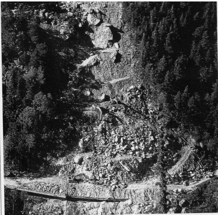
L'ultima frana caduta sulla strada di Valgrisenche
